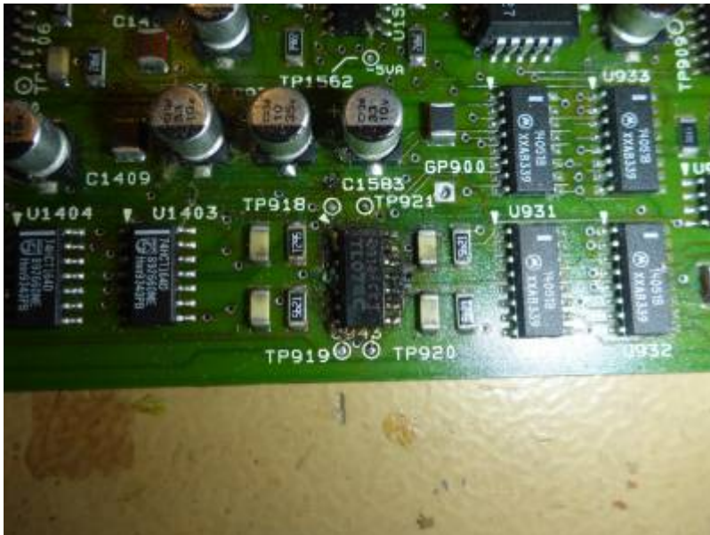
Ein weiterer Ausschnitt des Acquisition-Boards
